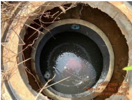
บ่อบำบัดน้ำก่อนเข้าสู่ระบบบำบัดน้ำเสียของอาคารที่พักผู้โดยสาร ชุดที่ 2
