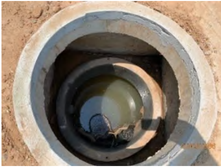
บ่อบำบัดน้ำก่อนเข้าสู่ระบบบำบัดน้ำเสียของอาคารที่พักผู้โดยสาร ชุดที่ 1
